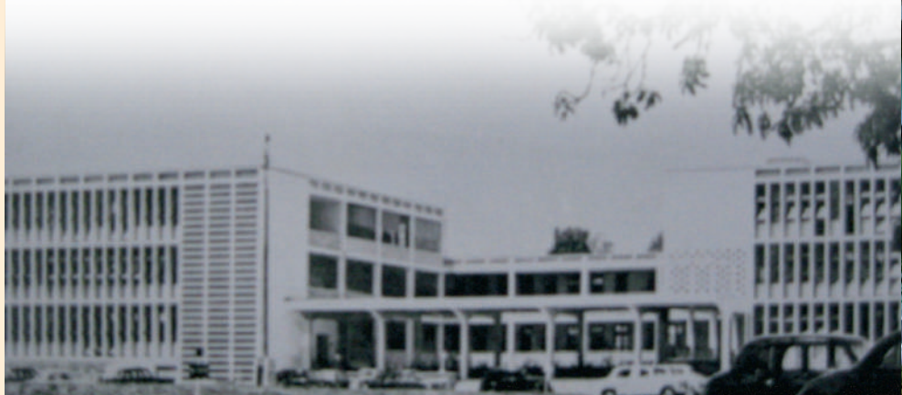
Jabatan Perangkaan Cawangan Sabah di Bangunan Setiausaha Kerajaan Negeri Department of Statistics, Sabah Branch at Bangunan Setiausaha Kerajaan Negeri
